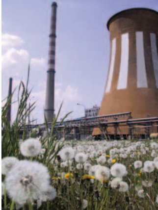
Elektrociepłownia Gorzów power plant
